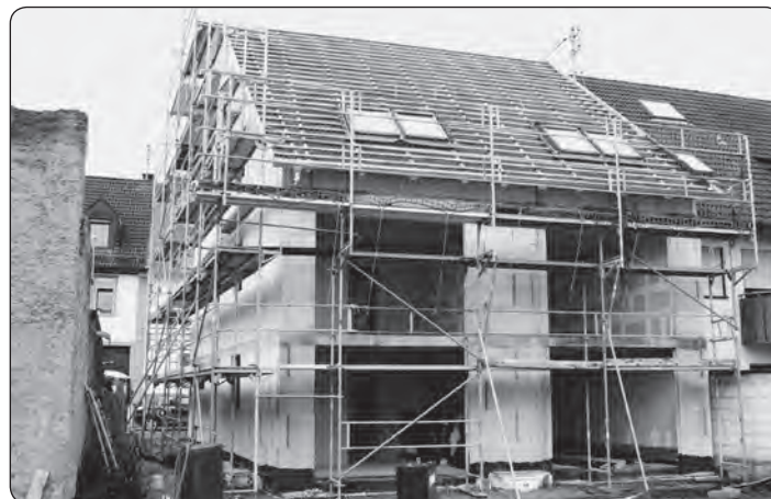
Das aktuelle Bauprojekt der Stiftung in Durlach-Aue
