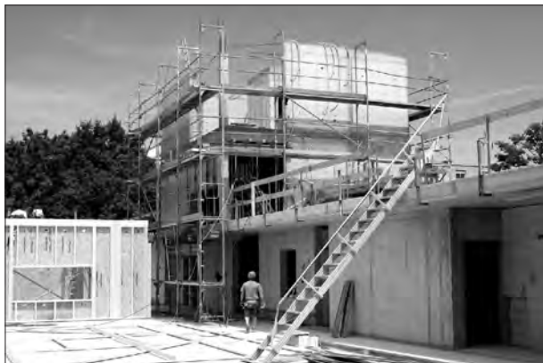
Baufortschritt nach Plan beim Lebenshilfe-Haus in der Steinhäuserstraße - Ende Juli wird Richtfest sein.
