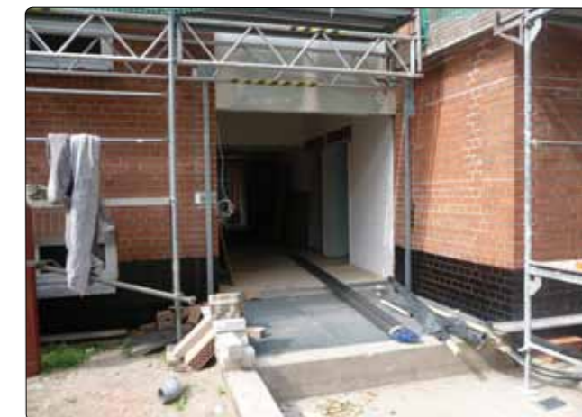
der neue Eingangsbereich entsteht
