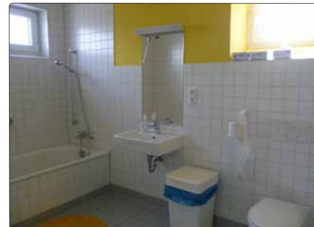
Blick in ein neues Badezimmer
