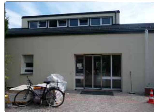
der Verwaltungstrakt mit neuer Fassade
