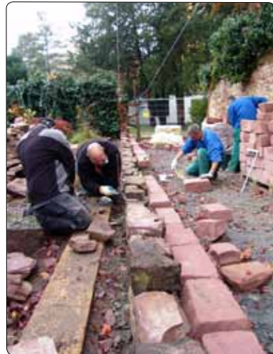
Der Bau einer Natursteinmauer ist anspruchsvoll.
